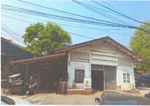
รูปภาพที่ ๑ ด้านหน้าอาคาร ทิศตะวันออก
