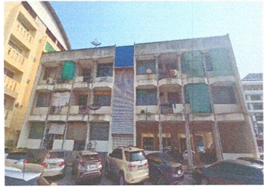
รูปภาพที่ ๒ ด้านหลังอาคาร ทิศตะวันตก
