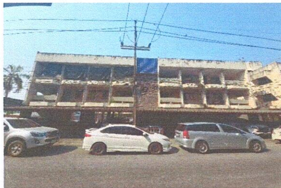
รูปภาพที่ ๑ ด้านหน้าอาคาร ทิศตะวันออก
