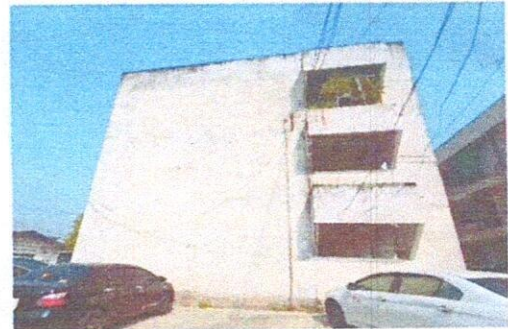
รูปภาพที่ ๔ ด้านข้าง(ซ้าย)อาคาร ทิศใต้
