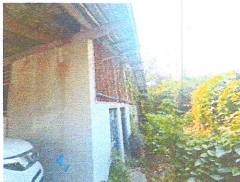
รูปภาพที่ ๒ ด้านหลังอาคาร ทิศตะวันตก
