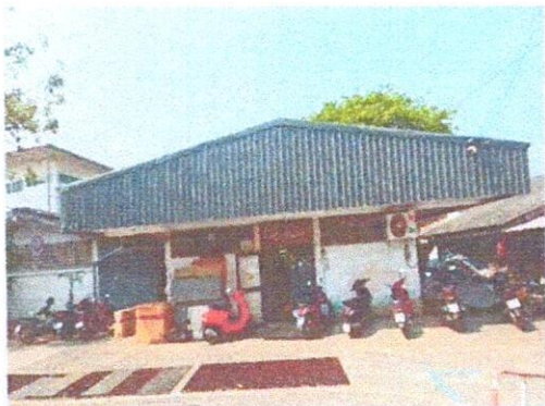
รูปภาพที่ ๑ ด้านหน้าอาคาร ทิศตะวันออก
